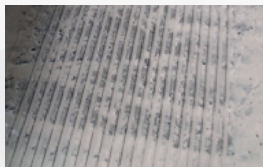
Rillenprofil in einer Betonfläche
